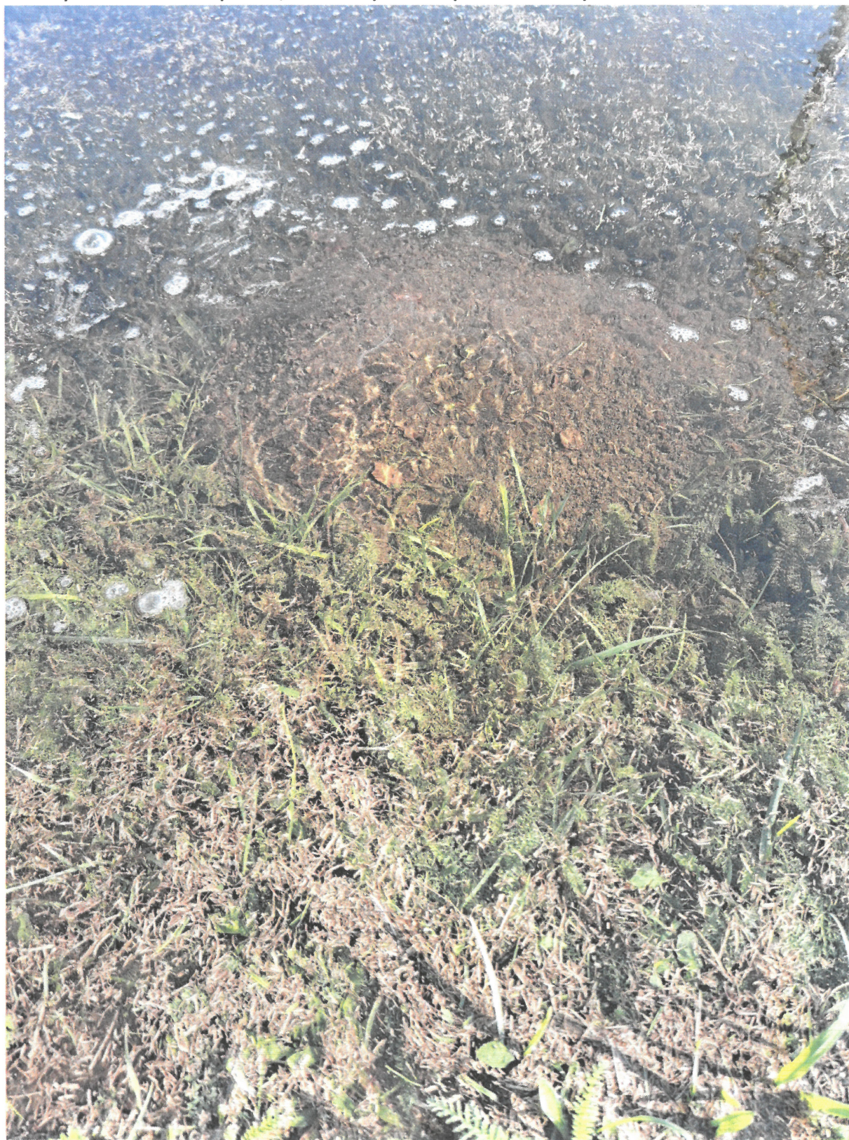
Průsaky PB hrází Polního potoka, Novosedly – detail průsakové cesty
